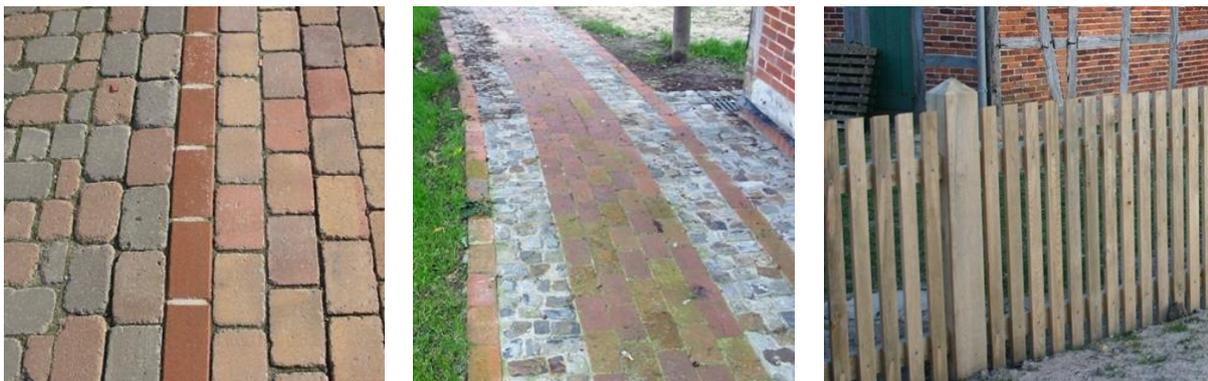
Abb. 82 Beispiele: gerumpeltes Betonrechteckpflaster, Naturstein/Klinker, Holz-Staketenzaun
