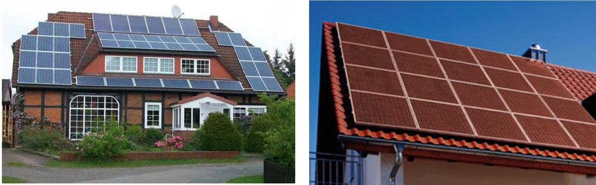
Abb. 81 Negativbeispiel (links): weder farblich noch funktional abgestimmte Anlage und Positivbeispiel (rechts): farblich angepasste Aufdach-Anlage mit ruhigem Gesamterscheinungsbild
