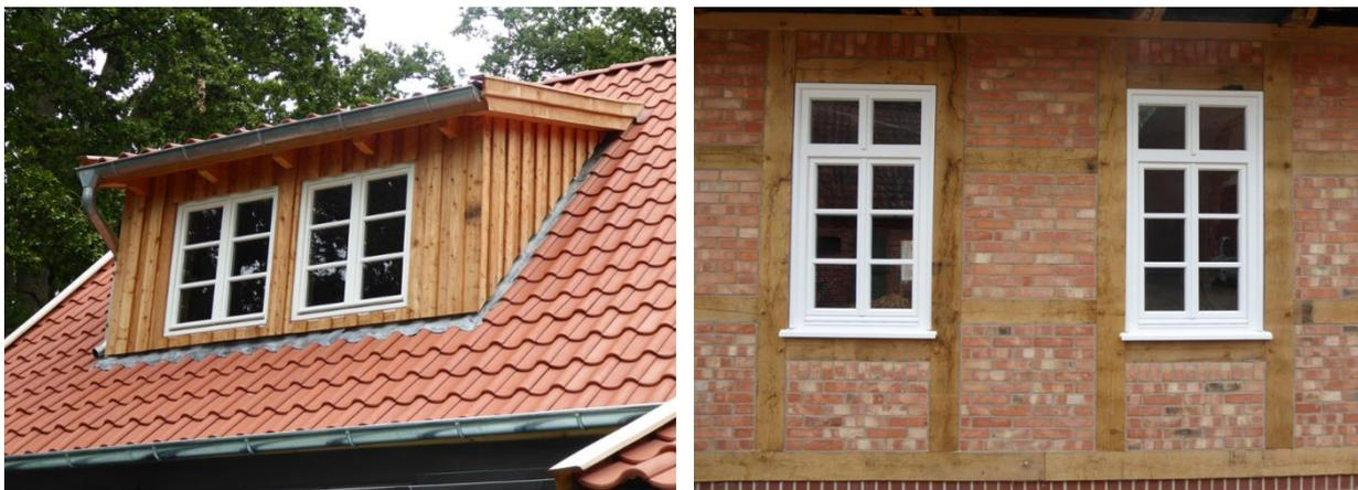
Abb. 79 Beispiele: Neue Dachgaube mit Fenstern und Holzverschalung, erneuerte Fachwerkfassade
